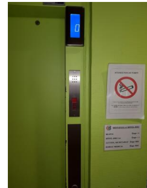
Commande palière du niveau principal
